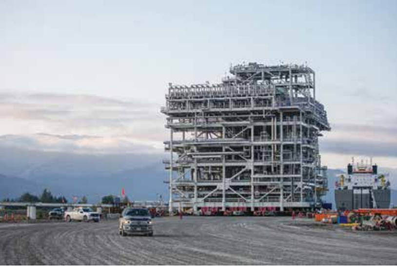
Modular delivery at LNG Canada Kitimat.
