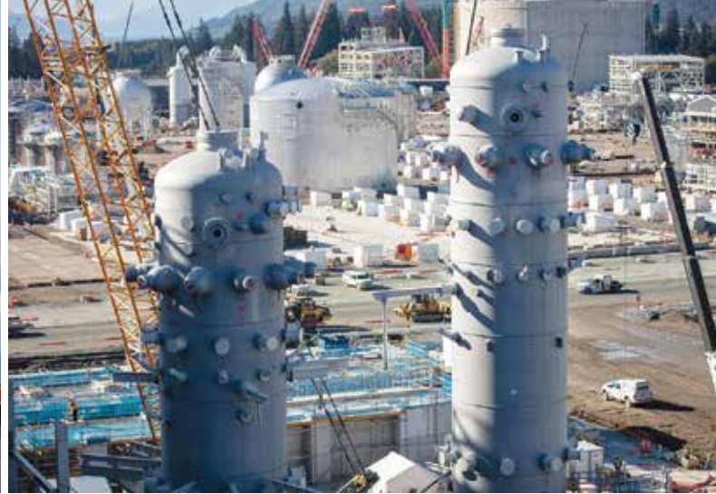
LNG Canada site at Kitimat.
